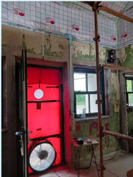
Test Zadmuchu Blower Door
