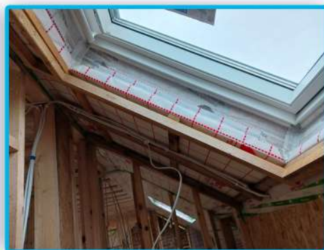
Szczegóły uszczelniania elementu dachowego
